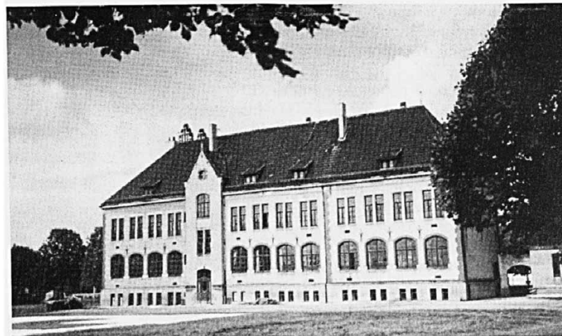
Leonhard-Sachs-Schule von Süden (Goldbacher Straße), 1914/18
