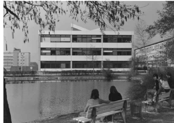
1973 : erster Erweiterungsbau am Schwanensee
